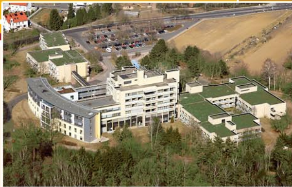
LUFTBILD GESAMTER KOMPLEX
